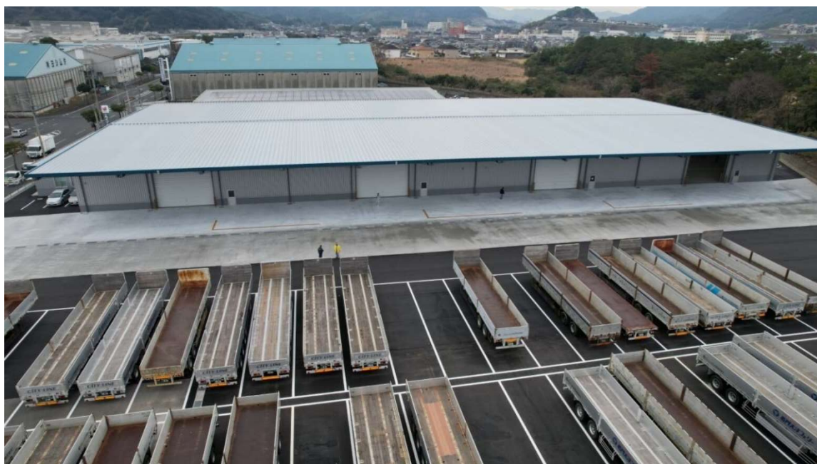
(倉庫外観写真)
